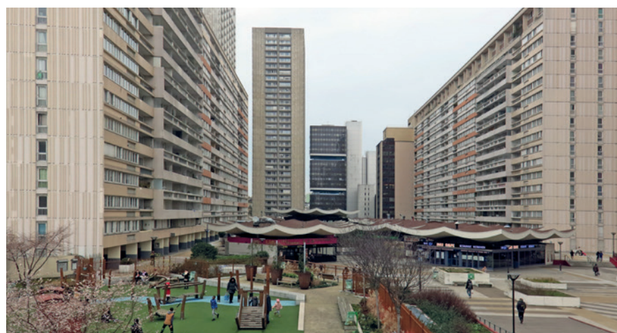
Vue sur la galerie Mercure de la dalle des Olympiades
